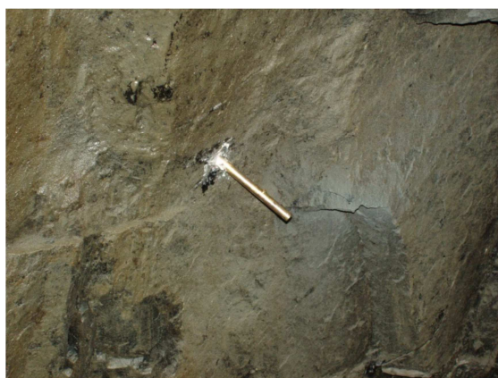
Obr. 8. Mosazný trn ve stropě
