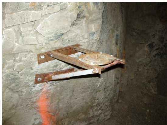
Obr. 6. Ocelová konzole (měřický stolek)
