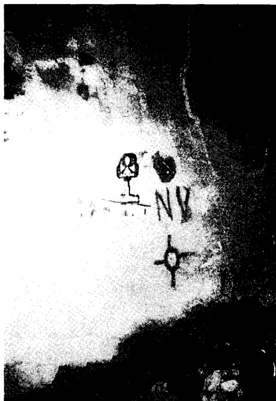
Obr. 6 Spôsob stabilizácie bodov VS v podzemí (Foto: A. Kopáček)
